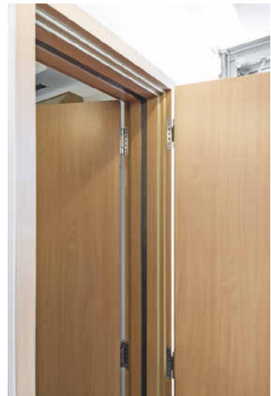
Doppeltür-Konstruktion mit 70 mm Schallschutztür (SK4) nach außen und 48 mm Schallschutztür (SK2) nach innen ins Studio.
