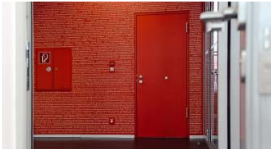
Moderne Brandschutztür, stumpf einschlagend mit flächenbündiger Zarge und verdeckt eingebautem Schließer.
